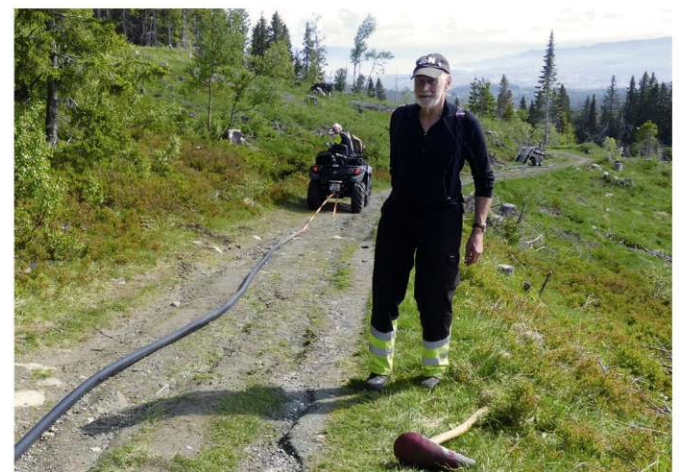
Gamle vannledninger fjernes fra Akebakken
